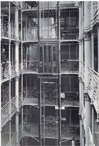
Vista del patio interior del depósito general de libros. Madrid, BNE. 17/228/14.
